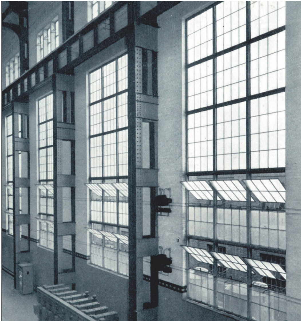
Stahlfenster an historischer Arbeitsstätte
