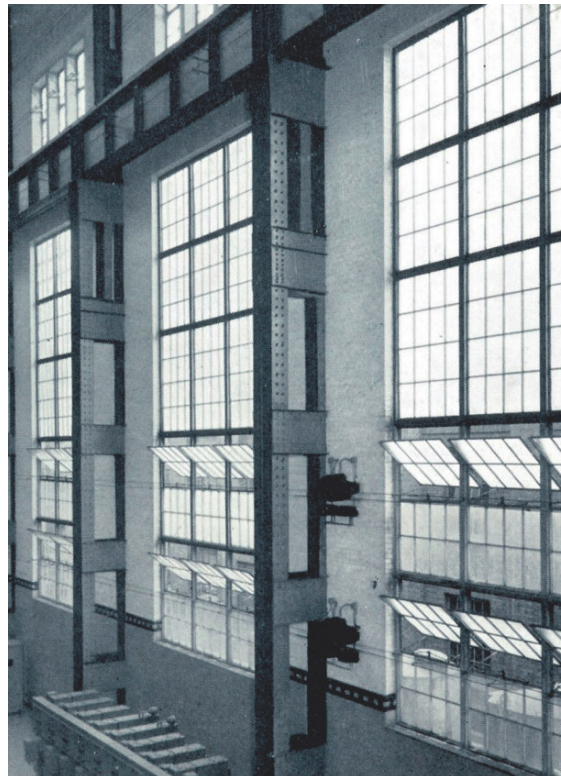
Stahlfenster an historischer Arbeitsstätte
