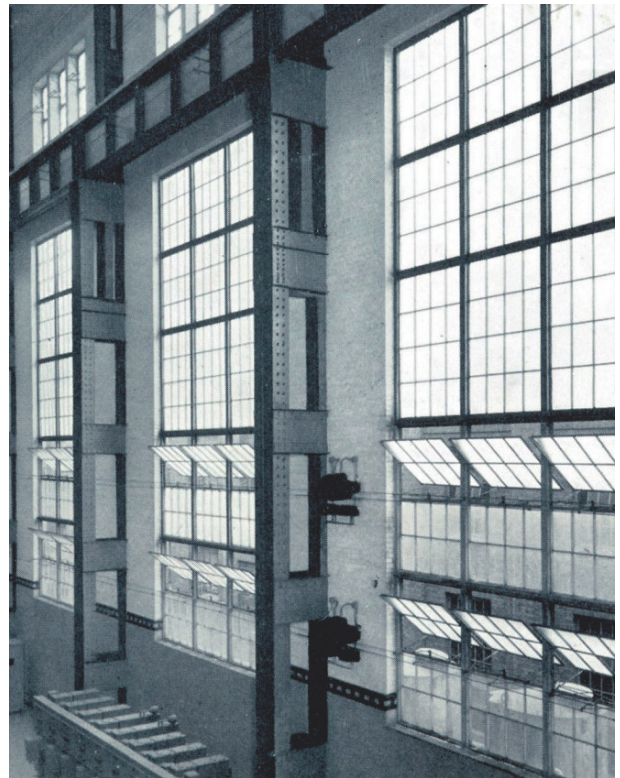
Stahlfenster an historischer Arbeitsstätte
