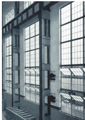
Stahlfenster an historischer Arbeitsstätte
